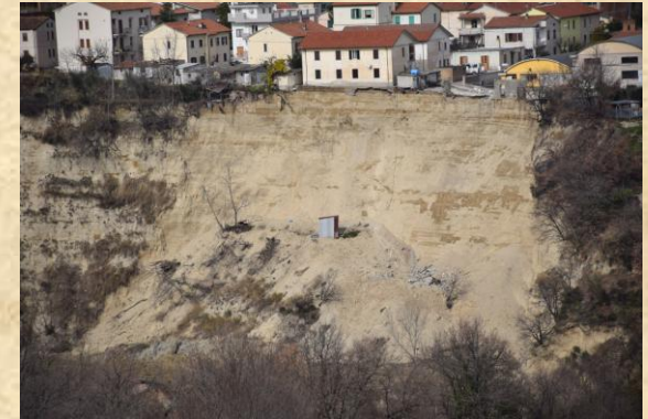
Panoramica della Frana di Campli
